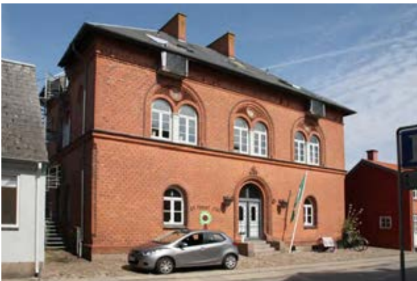
Teknisk Skole. Oprettet 1865. Eksisterende bygning er fra 1890.
