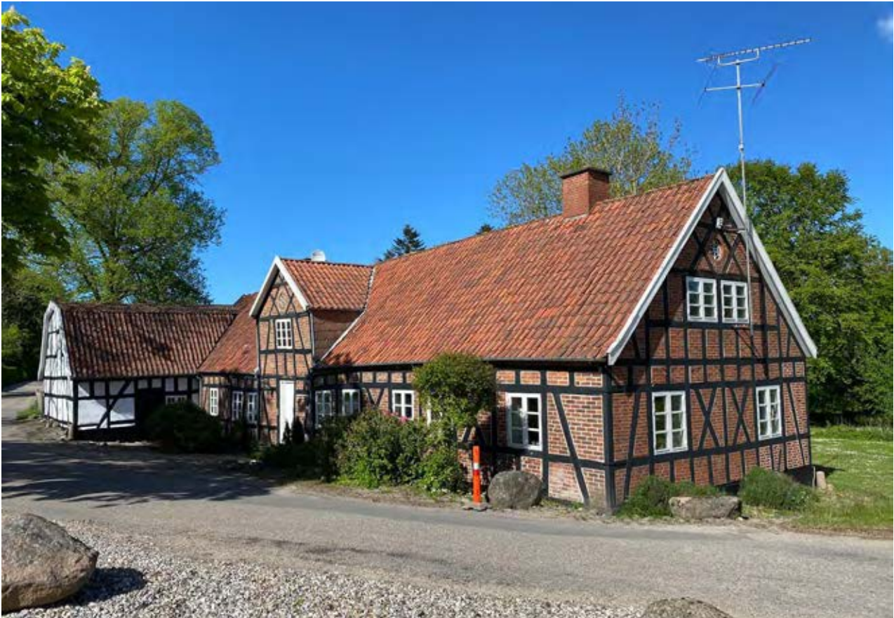
Rugårds Mølle set fra syd. Det interessante stuehus ser ud som om bindingværket ikke blot er til pynt. Derfor må man antage, at tavle- ne mellem træværket oprindeligt var lerklinede, og blev skiftet ud med mursten i anden halvdel af 1800-tallet.
