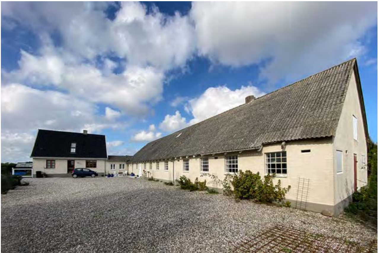
Moderniseret husmandsbrug ved Kørup. Bygningerne er blevet pudset, men strukturen er bevaret.
