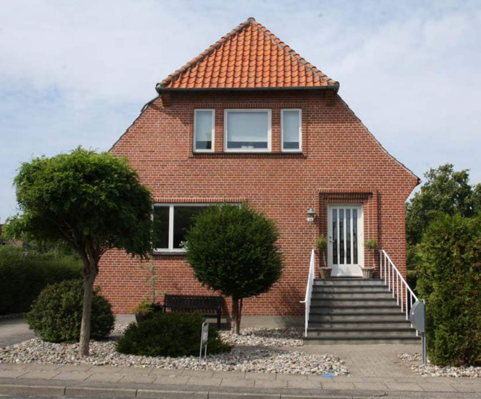
Murmestervilla fra ca. 1940. Bemærk der er ingen stik over døre og vinduer.
