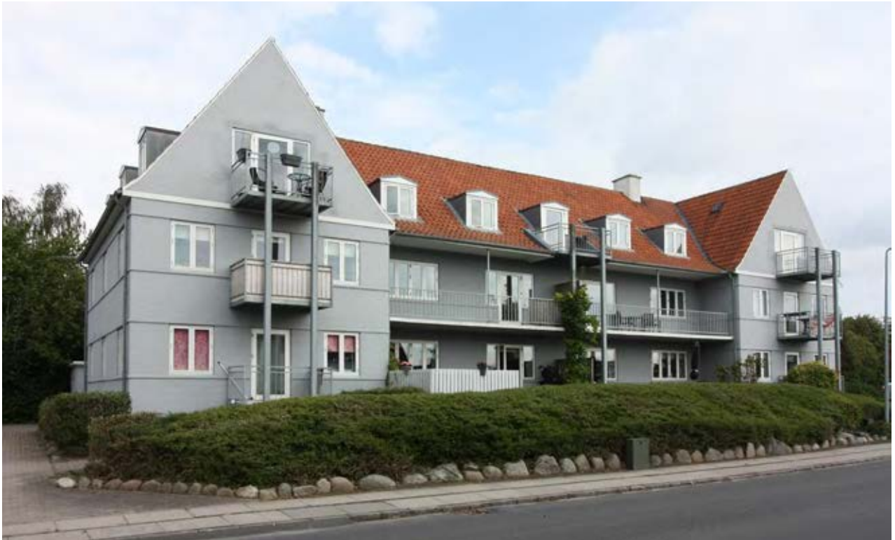
Aldersdomshjem fra 1956. Ændrede altaner. Byggeskikken er nærmest en sen funkis, som hører hjemme i 1940'erne.
