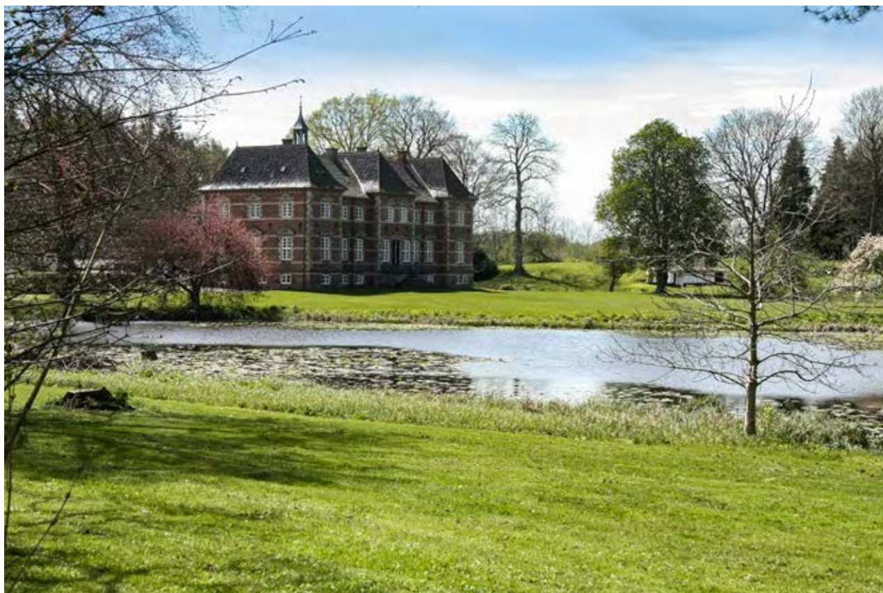
Man ser hovedbygningen hen over parkens sø, som også er mølledam. Den er bygget i 1874 i nederlandsk renæssancestil. Tidens stil. Arkitekten hed Knud Borring. Se også Østrupgård.
