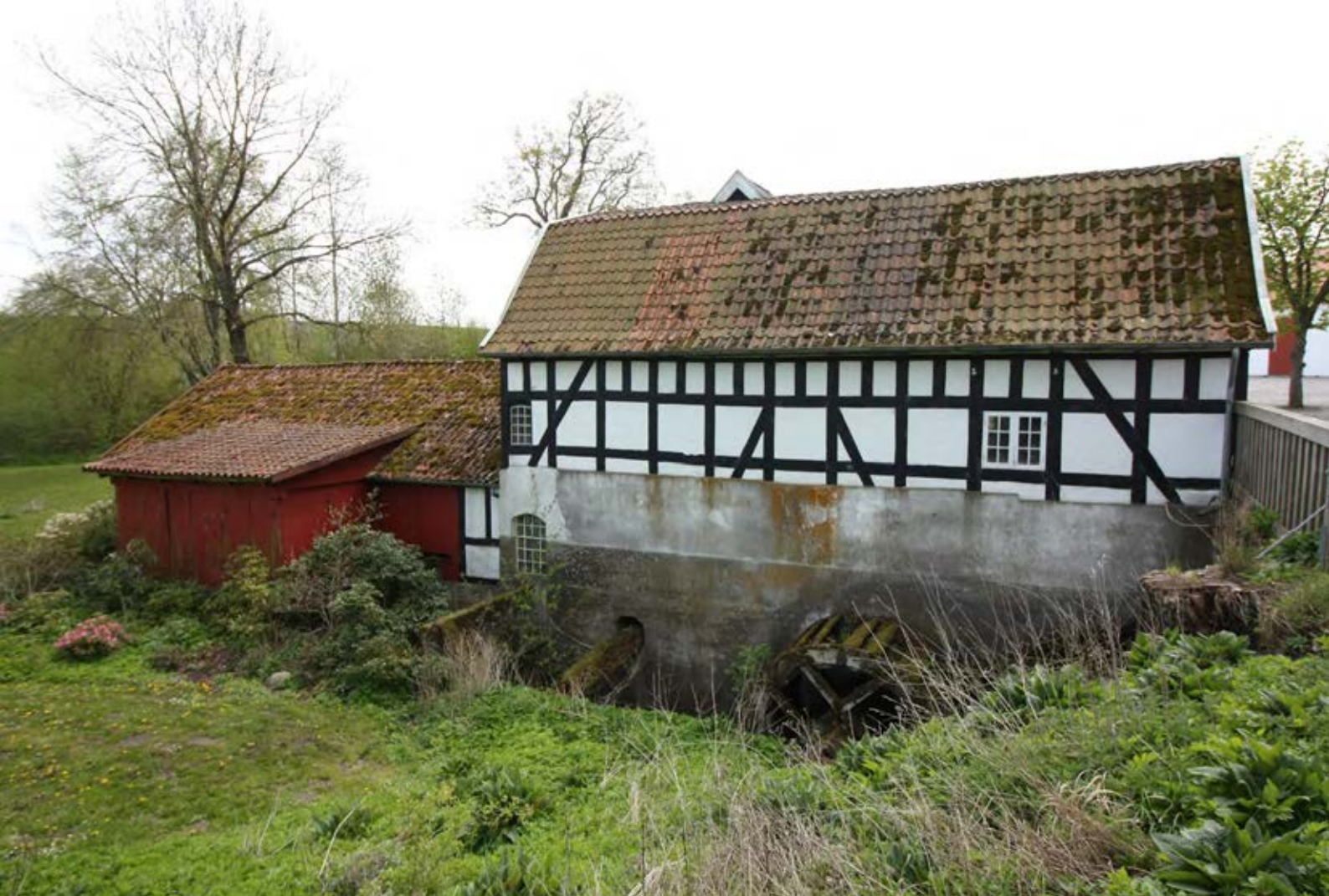
Rugårds Mølle set fra nord. Man ser møllebygningen, hvor værket blev drevet af to overfaldshjul. Til venstre ligger savmøllen. Møllebygningen er karakteristisk nordfynsk bindingsværk med ekstra løsholter og dokker lige under gesimsen. Se også stuehuset.
