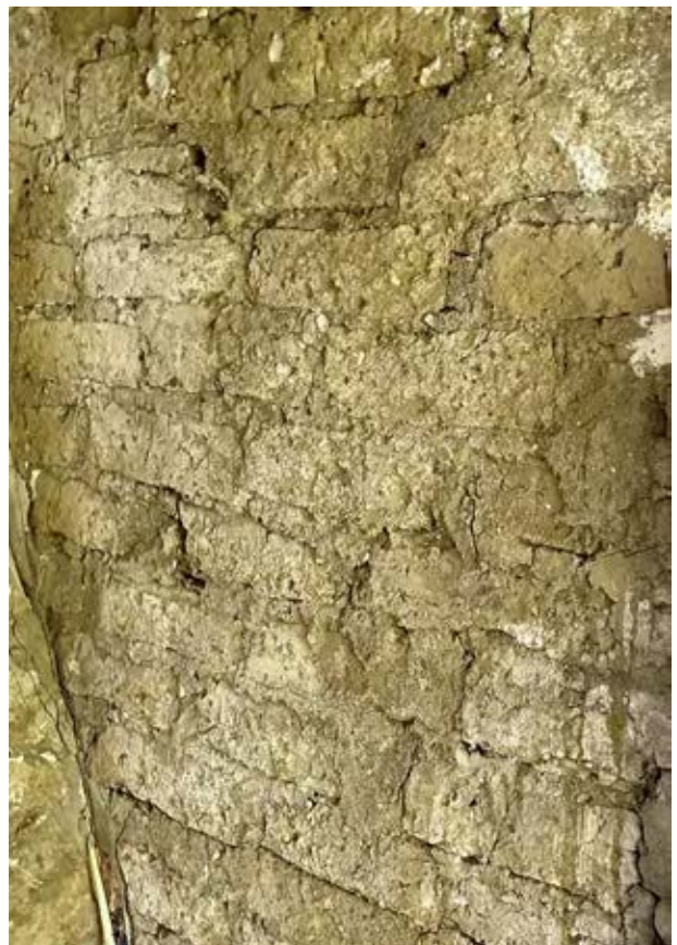
Væg muret af tørrede lersten. Disse billige sten blev brugt til indre vægge og tavler i bindingsværksbygninger indtil 1900-tallet.
