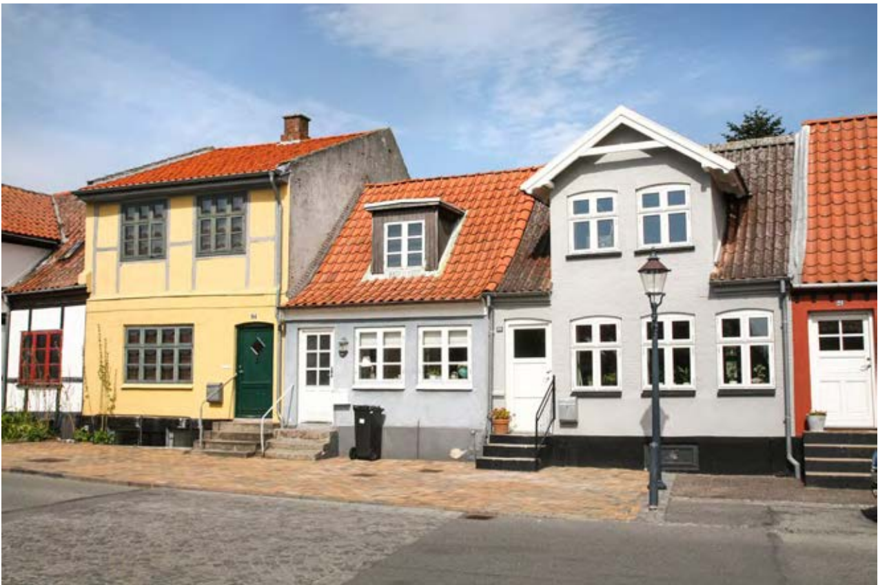
Byhuse. En – og to etager, ornamentalt bindingsværk, frontspids og svejtsrudhæng. Alle fra 2. halvdel af 1800-tallet.
