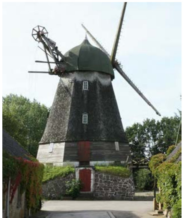
Møllen set fra nord. Spånbeklædningen kan anes. Man ser 'bakken' eller 'kælderen' som muliggør, at man kan gå og køre ind under den.
