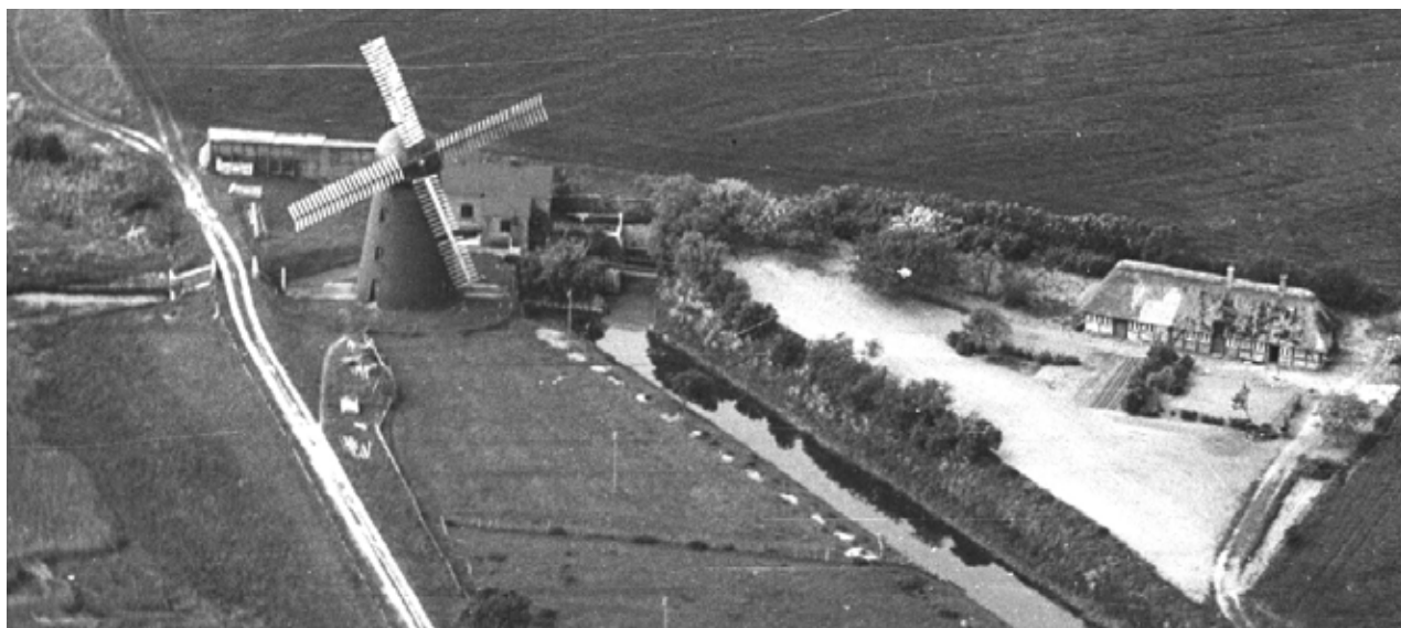
Agernæs Pumpemølle og kanal ca. 1950. Fot. Det Kongelige Bibliotek. Danmark set fra luften.
