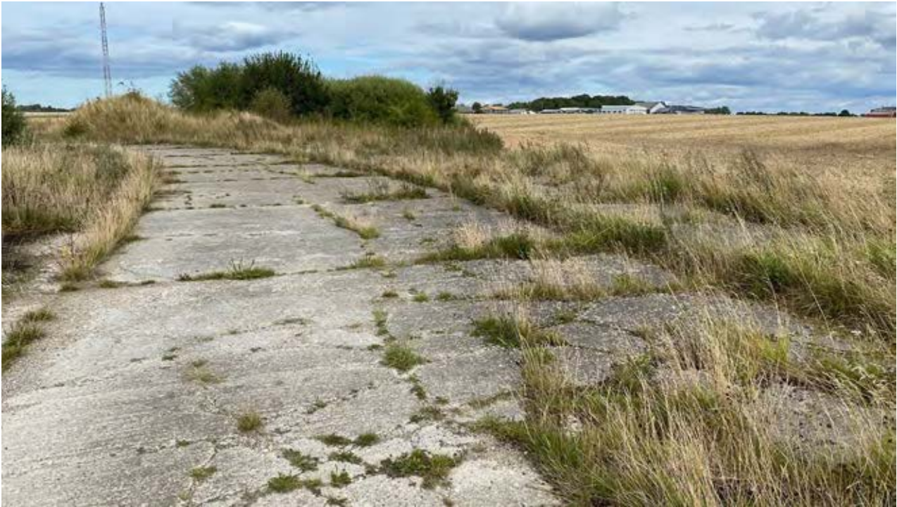
Rullebanen med betonpladebelægning op til flyvepladsens vestdel.
