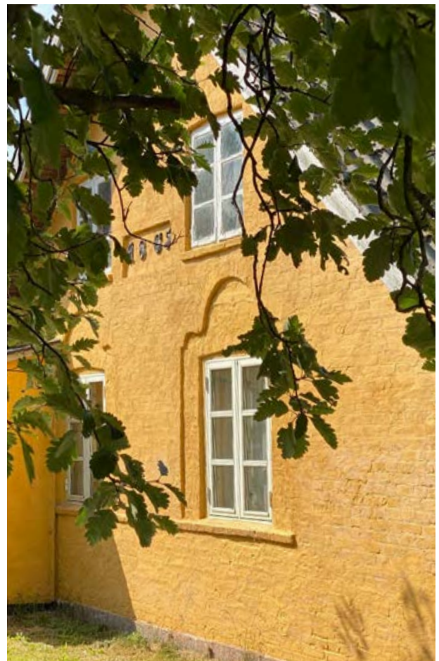
En detaljerig gavl fra 1865 med barokke virkemidler så som indramningen af vinduet.
