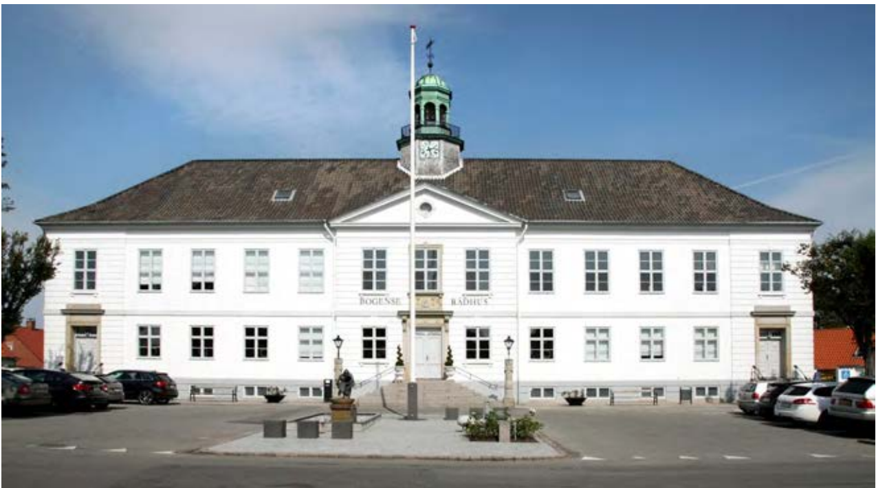
Senklassicistisk offentlig bygning fra 1921. Fire skorstene er væk. Der er sat nye tagvinduer i.
