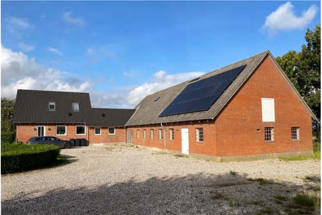
Husmandsbrug med stuehus og stald fra 1954 ved Kørup.
