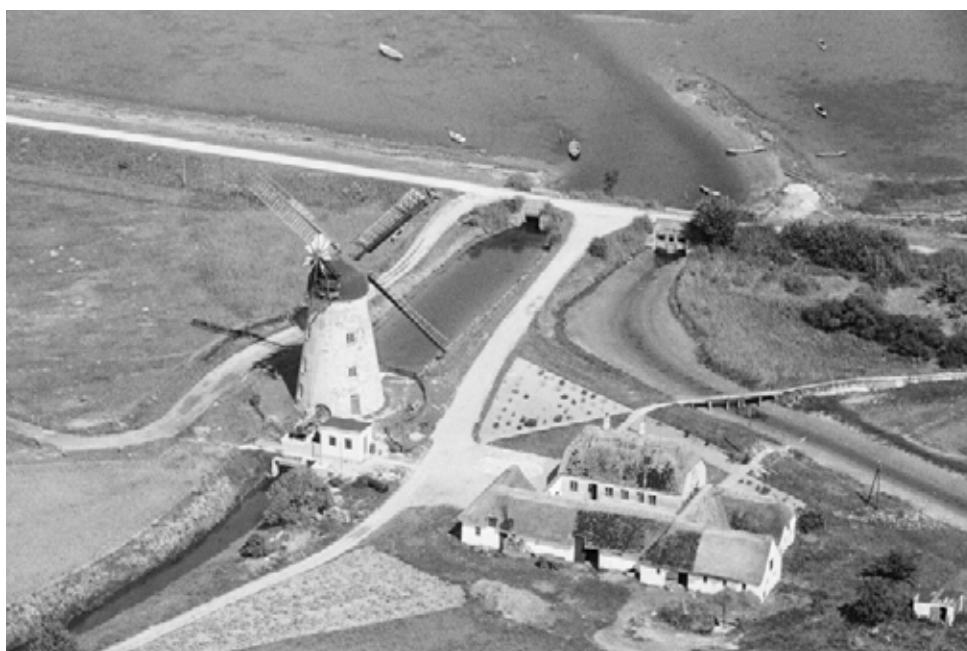
Bogø Pumpemølle-miljø (fra 1872) i 1948. Bemærk pumpekanalen som løber under møllen ud gennem dæmningen. Landvandskanalen løber til højre for det bebyggede område.
