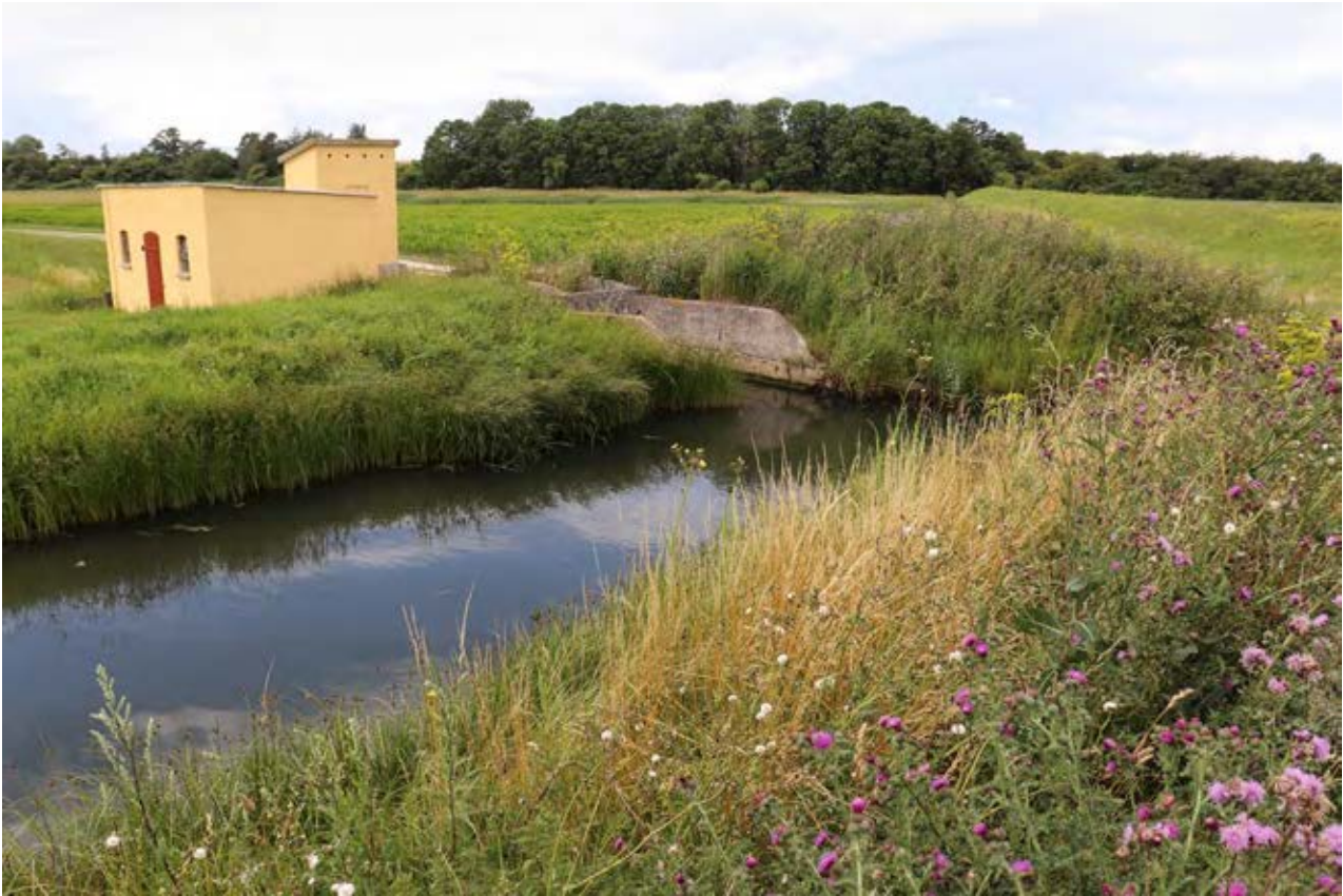
Pumpestationen leder vandet fra pumpekanalen ud i landvandskanalen. Herfra løber det gennem dæmningen ud i Nærrå Strand.
