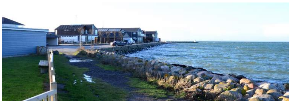
Figur 4-25 Lav stenkastning ved campingpladsen.
