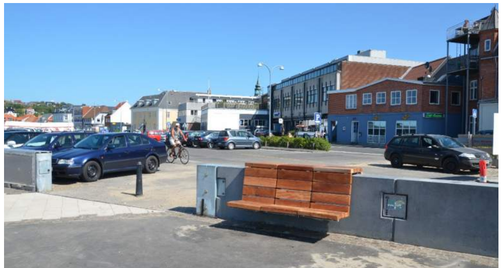
Figur 4-20 Oversvømmelsesbeskyttelse med smal betonmur og mobile porte i Lemvig.
