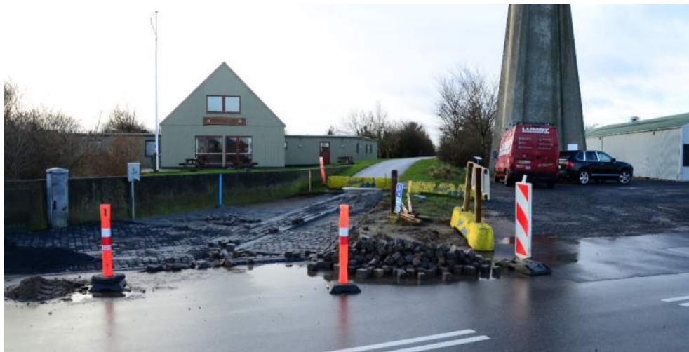
Figur 4-9 Eksisterende dige og højvandsbeskyttelsesmur i bunden af havnebassinet.
