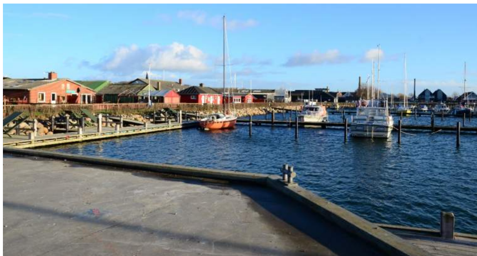
Figur 4-10 Bygninger på lavtliggende arealer i vestlig del af havnen.
