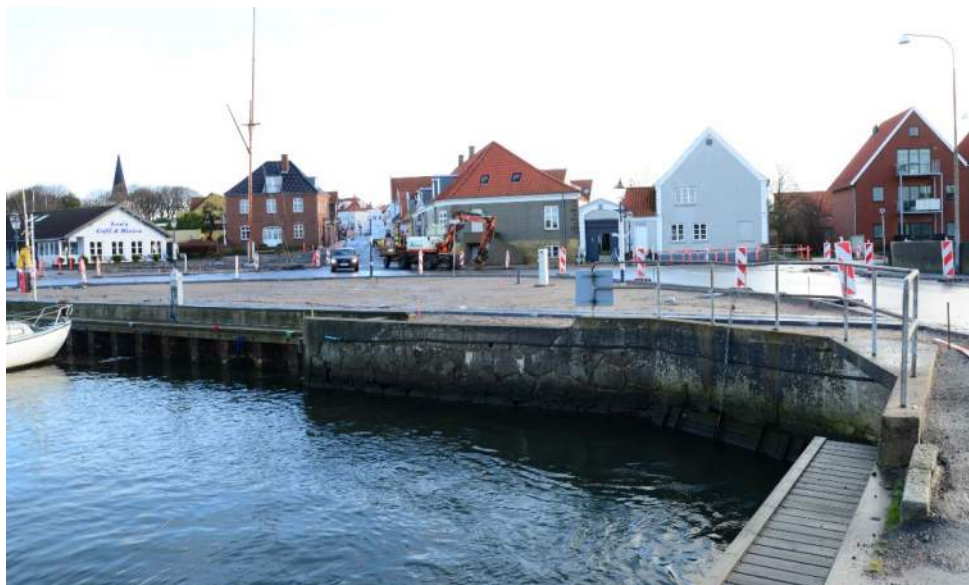
Figur 4-8 Udløb af landkanal og højvandsklap i bunden af havnebassinet samt højdedrag til venstre og eksisterende højvandsbeskyttelsesmur til højre.
