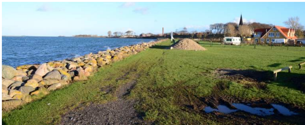
Figur 4-18 Skråningsbeskyttelse ved campingpladsen.
