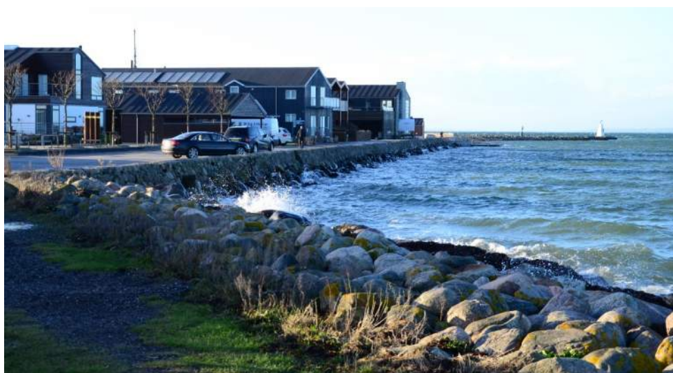
Figur 4-16 Østlig havnemole med lodret mur.
