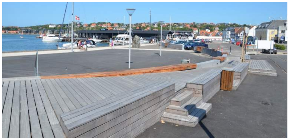
Figur 4-21 Oversvømmelsesbeskyttelse med smal betonmur og mobile porte i Lemvig.
