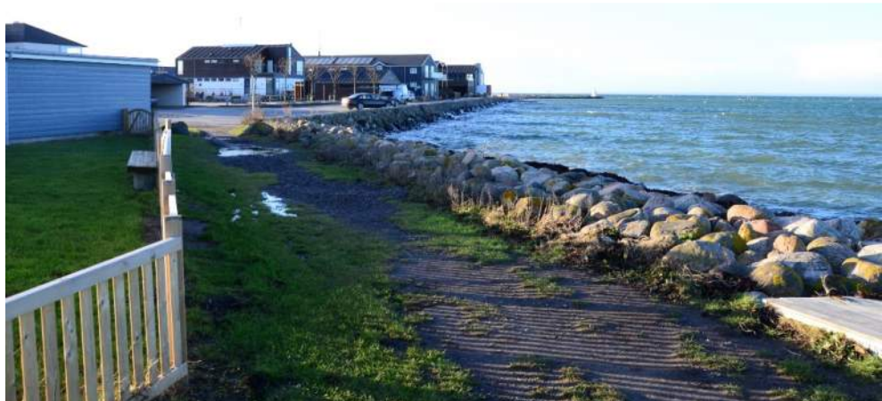
Figur 4-17 Skråningsbeskyttelse ved campingpladsen.
