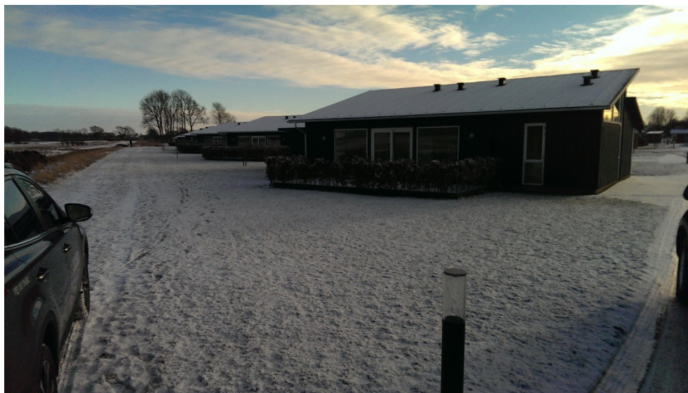
Figur 2 De udsatte huse ved HCA golf. Husene ligger uhensigtsmæssigt lavt i forhold til omgivende terræn.
