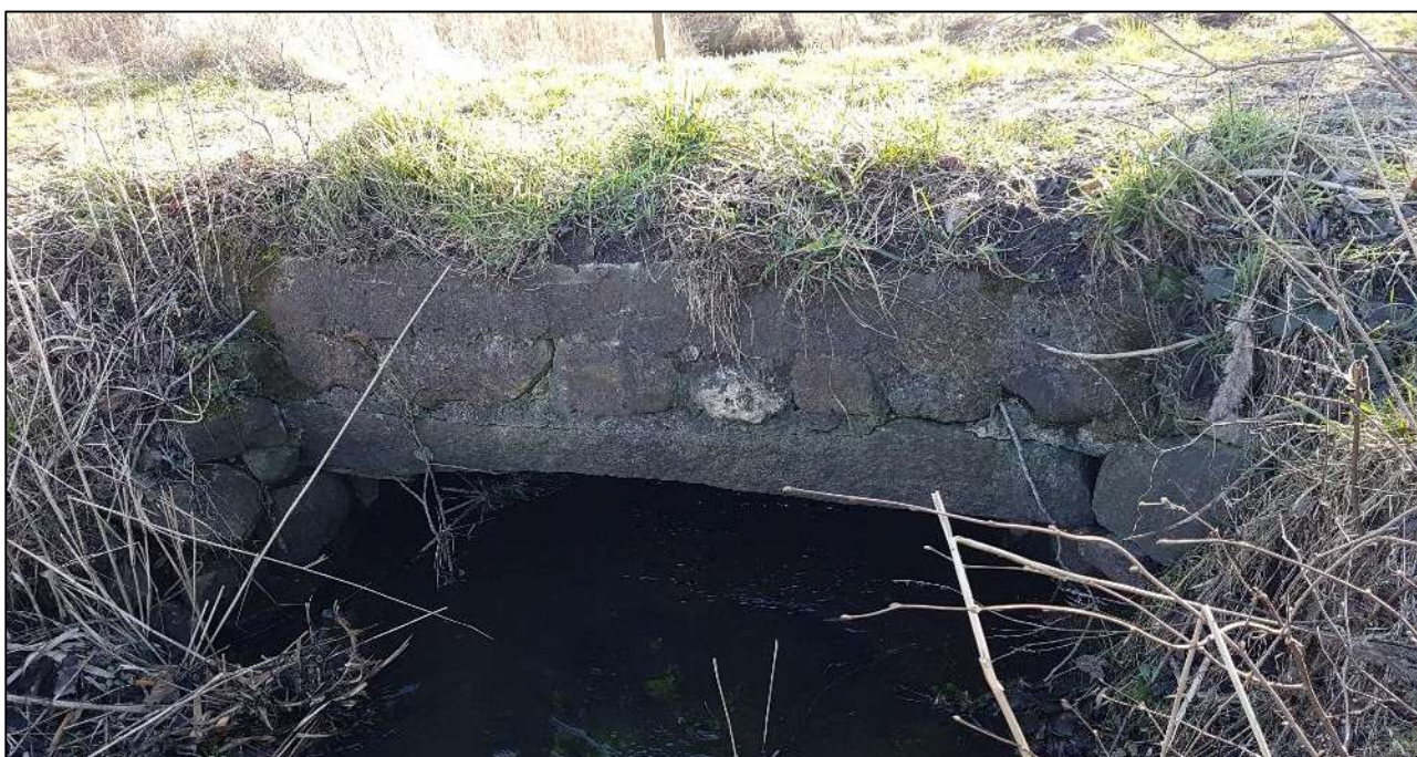
Figur 3: Stenkiste under markvej ved. st. 2.490 m.
