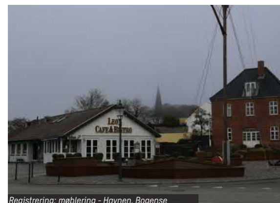
Registrering; møblering - Havnen, Bogense
