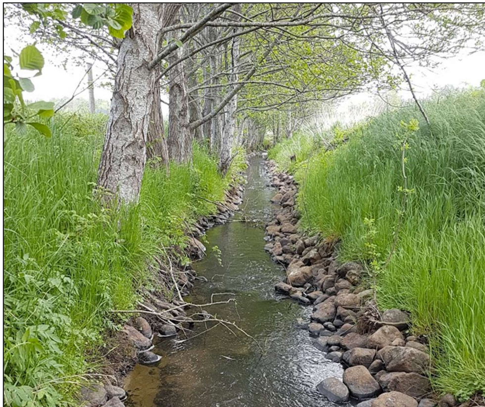
Figur 2: Stensikret forløb mellem st. 7.575 - 7.400 m.
