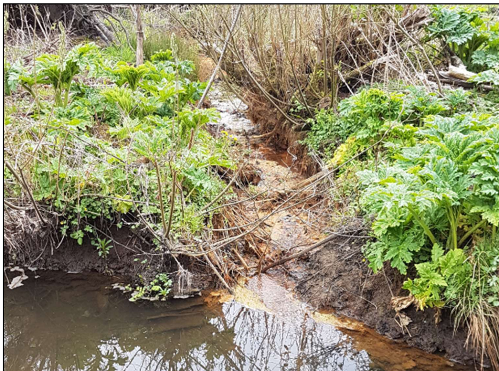
Figur 26: Okkerforekomst ved tilløb af grøft omkring st. 900 m.
