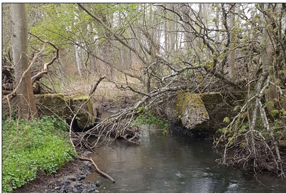
Figur 21: Tidligere engvandingsanlæg ved st. 2.498 m set opstrøms.
