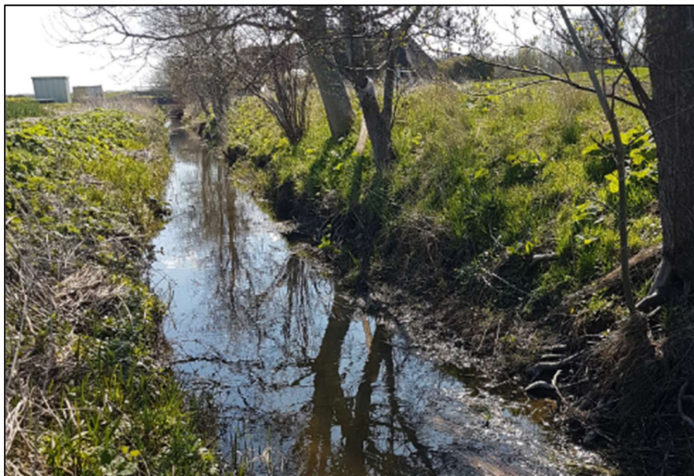
Figur 9: Vandløbet set medstrøms omkring st. 5.900 m. I baggrunden anes indløb under Vedbyvej.
