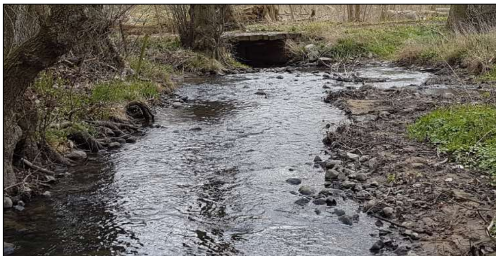
Figur 22: Nedstrøms engvandingsanlægget set medstrøms.
