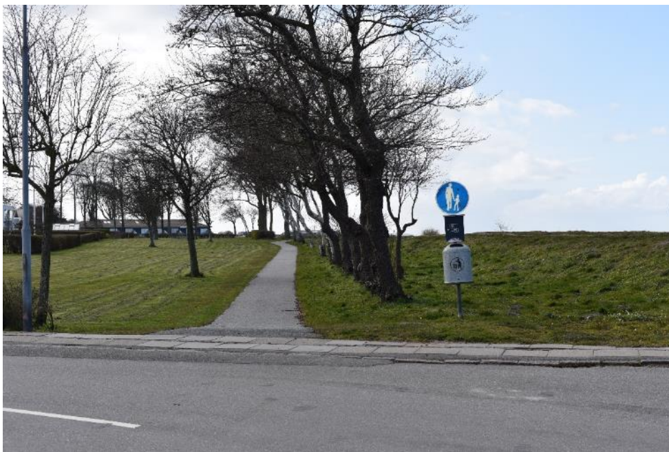
Figur 3-11 Foto: Strækning 9, eks. parkareal og dige set mod vest (Foto WSP)
