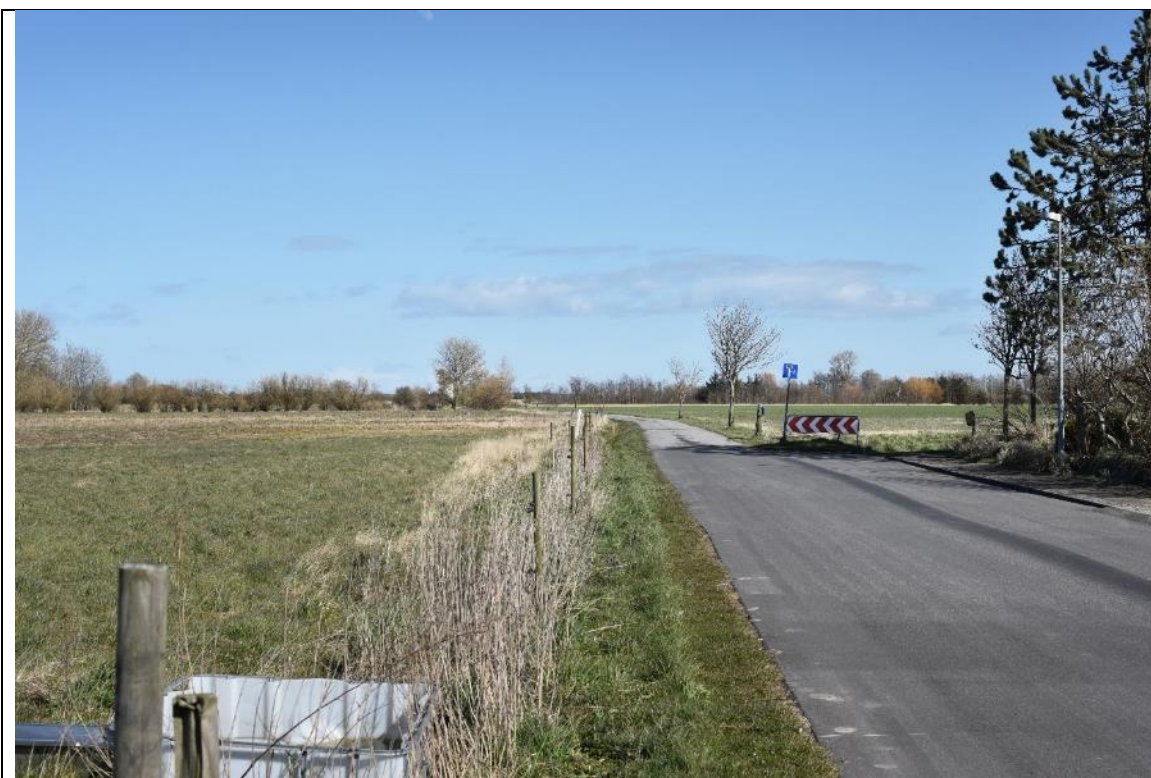
Figur 14-27: Fotostandpunkt 6 – Eksisterende forhold
