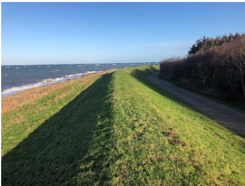
Figur 3-4 Foto: Strækning 2, eks. dige set mod nord (Foto WSP)
