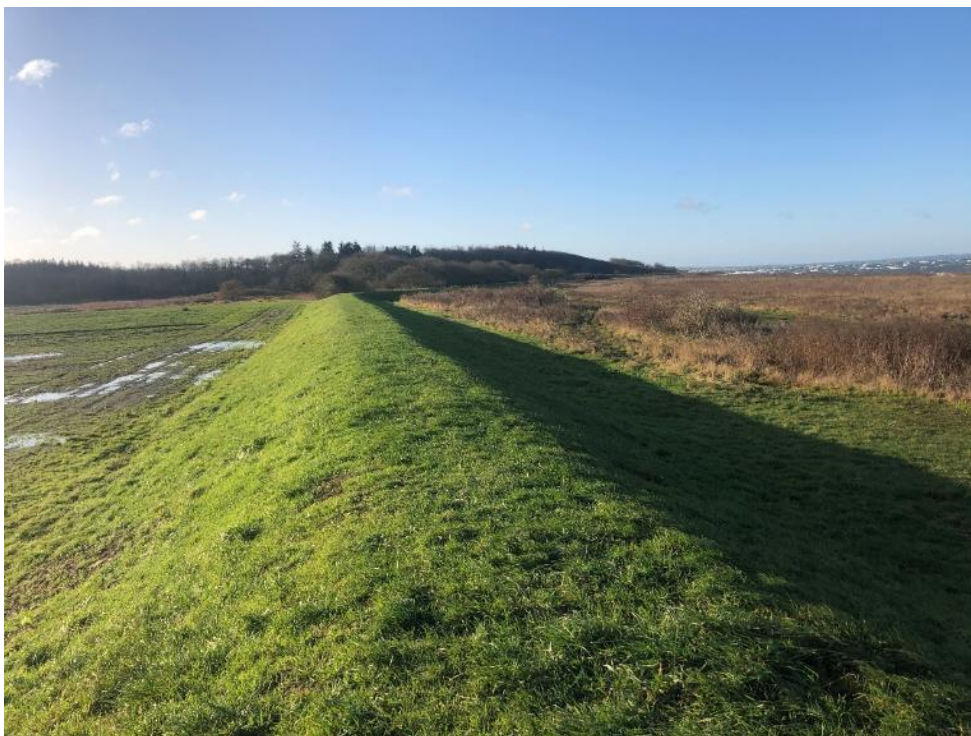
Figur 3-2 Foto: Strækning 1, eks. dige set mod syd. Fra den sydlige del af strækning 1. (Foto WSP)
