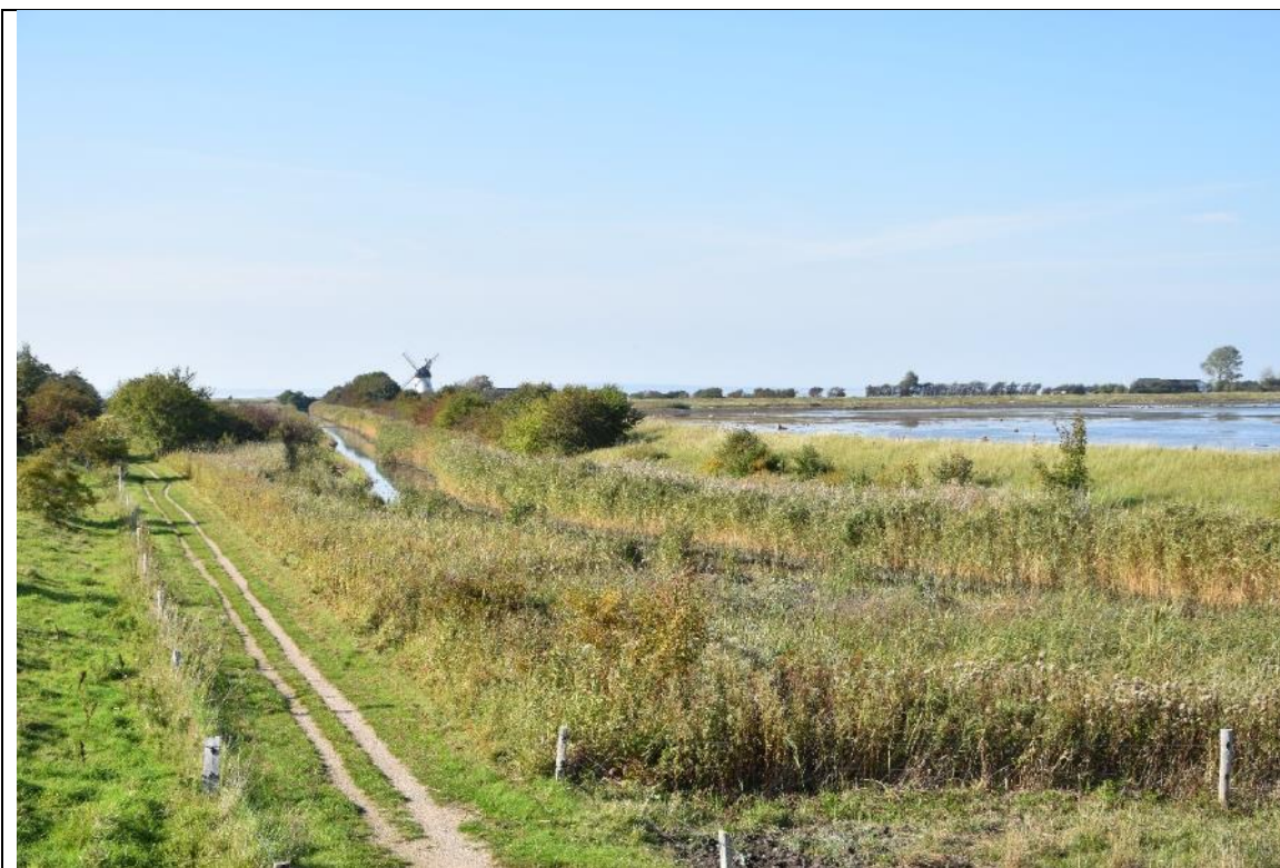
Figur 14-10: Det nye dige langs den omlagte del af Ålebækkens østside ved Østereng, med den bevarede hollandske pumpemølle på Store Stegø og det retablerede havareal ved Gyldensteen Strand til højre.
