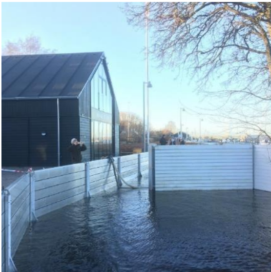
Figur 1-6 Mobil sikring ved stormflod, Roskilde januar 2022, Foto: WSP
