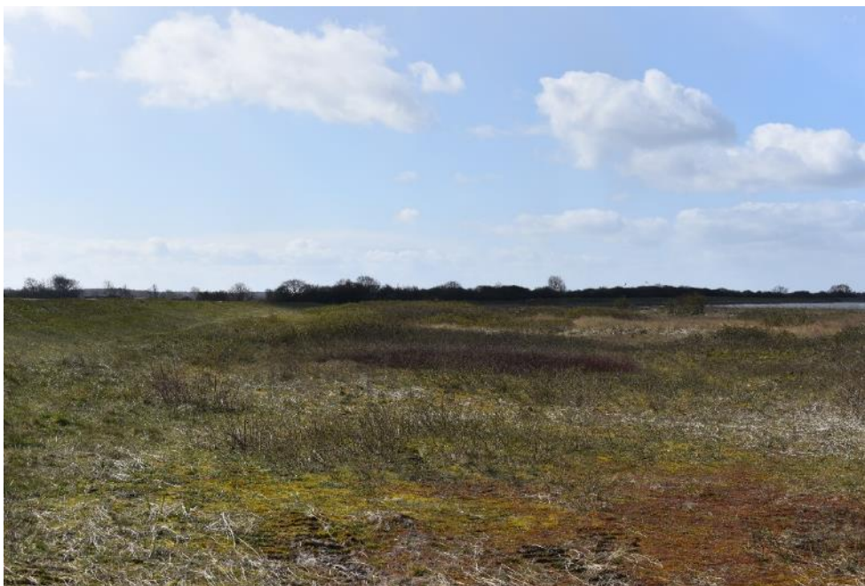
Figur 3-8 Foto: Strækning 6, eks. dige set mod vest (Foto WSP)
