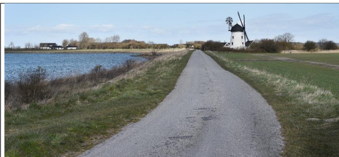
Figur 14-29: Fotostandpunkt 7 – Eksisterende forhold
