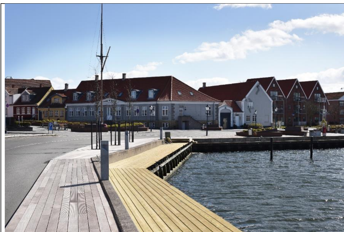
Figur 14-35: Fotostandpunkt 4 – Eksisterende forhold
