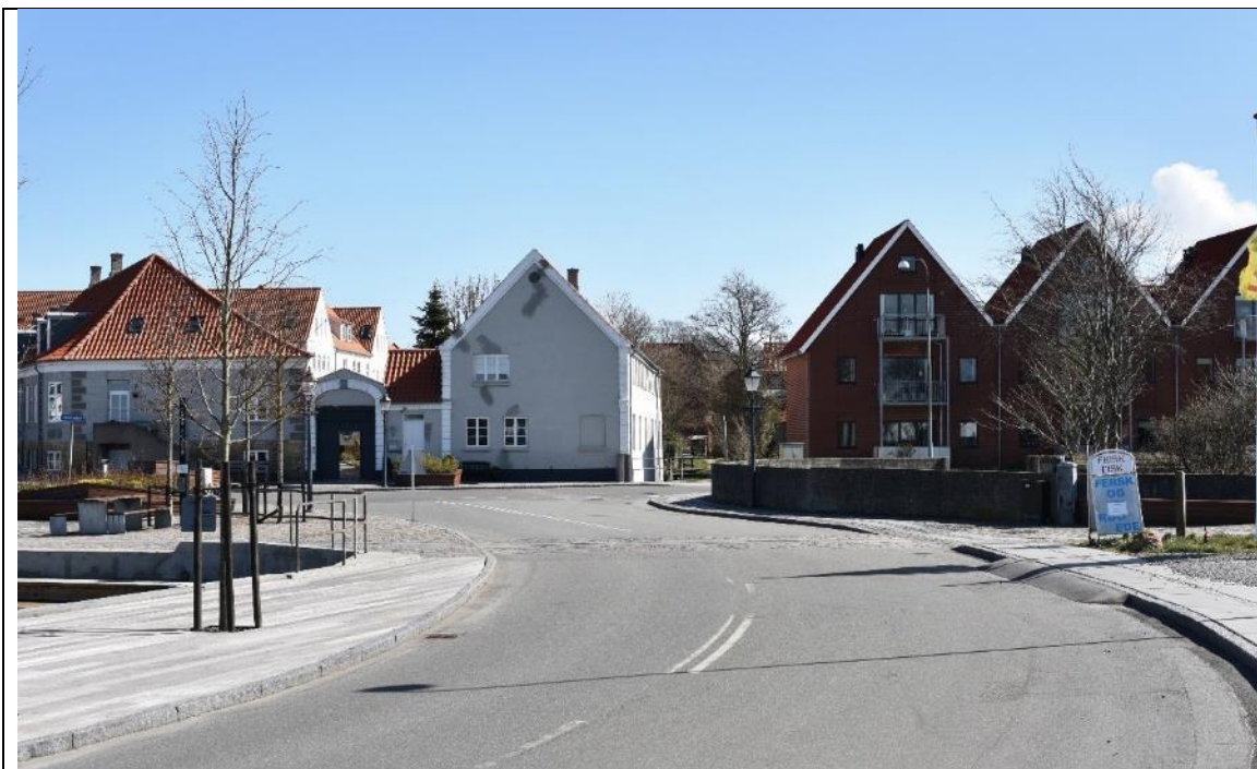
Figur 14-33: Fotostandpunkt 3 – Eksisterende forhold
