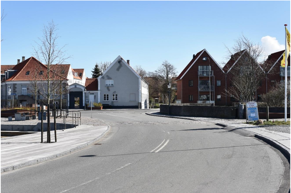
Figur 14.12 Fotostandpunkt 3 – Eksisterende forhold
