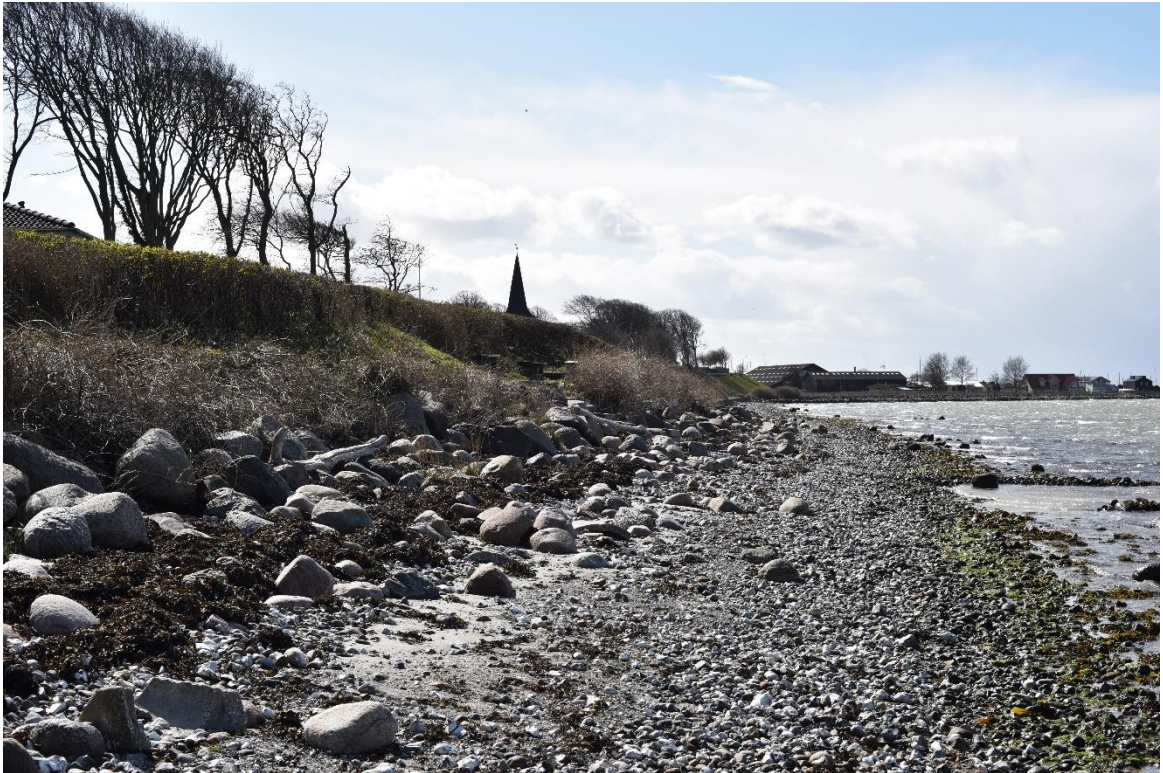
Figur 14.16 Fotostandpunkt 5 – Eksisterende forhold
