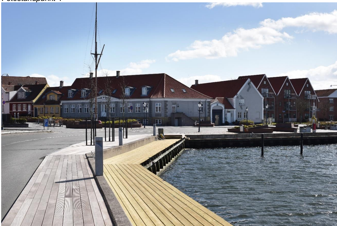
Figur 14.14 Fotostandpunkt 4 – Eksisterende forhold
