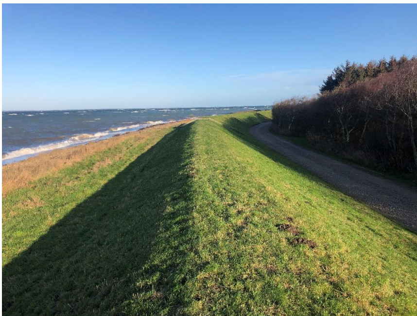
Foto: Strækning 2, eks. dige set mod nord (Foto WSP)
