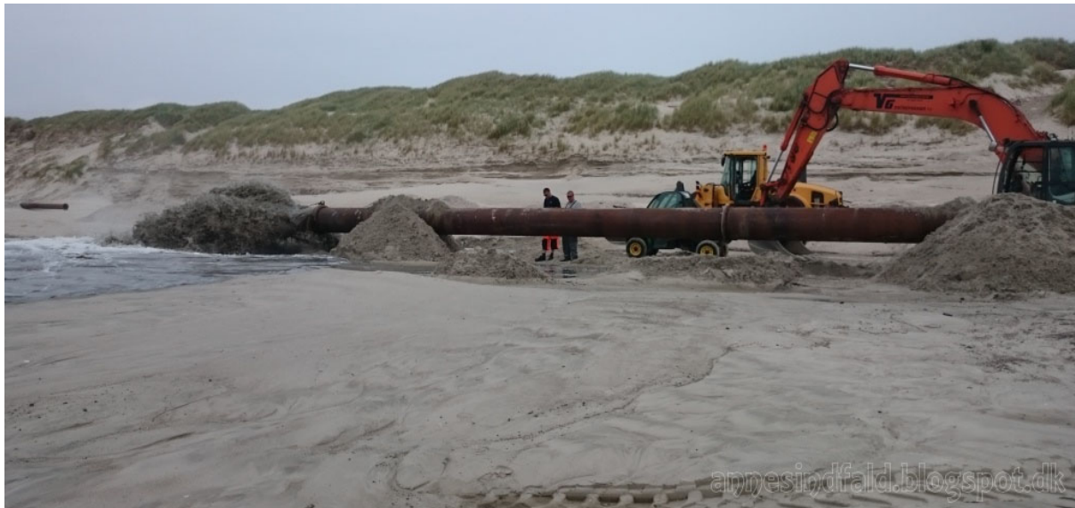
Foto: Sandfodring med anstilling af rørledninger på stranden.
