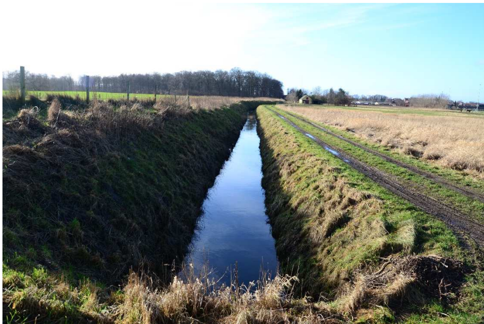
Figur 4-15 Østre Enges Landkanal set fra overkørsel ved Østre Enges pumpestation mod vest. Denne overkørsel fjernes.
