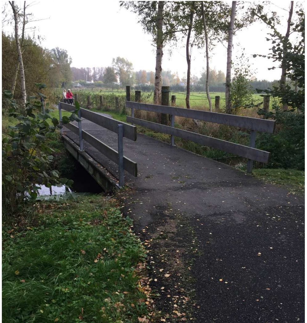
Figur 4-5 Stibro lige opstrøms det planlagte overløb
