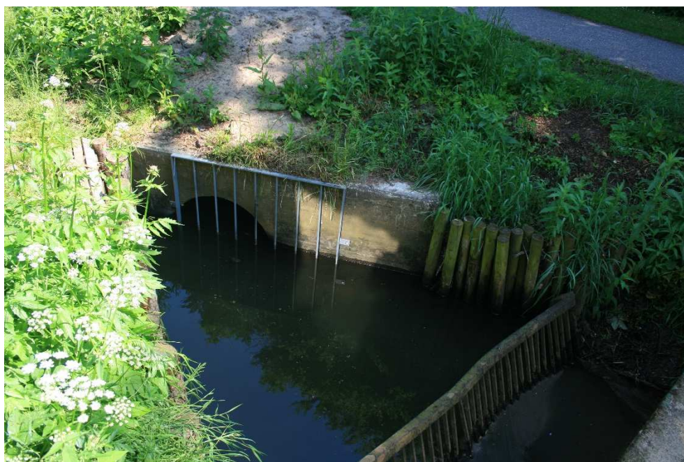
Figur 4-10 Indløbet til Østre Enges Landkanal fjernes
