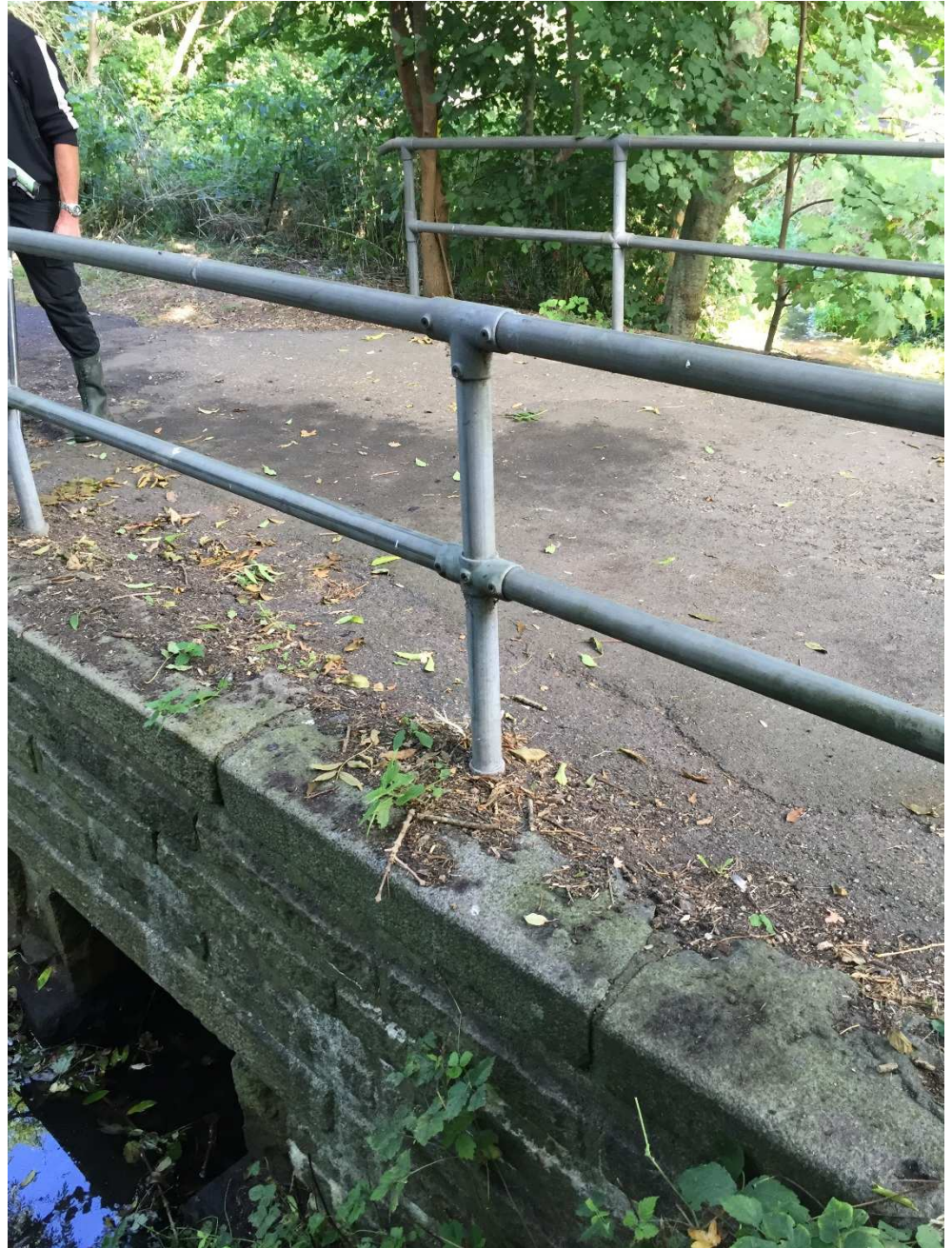
Figur 4-7 Banebroen over vandløb 4d skal fjernes
