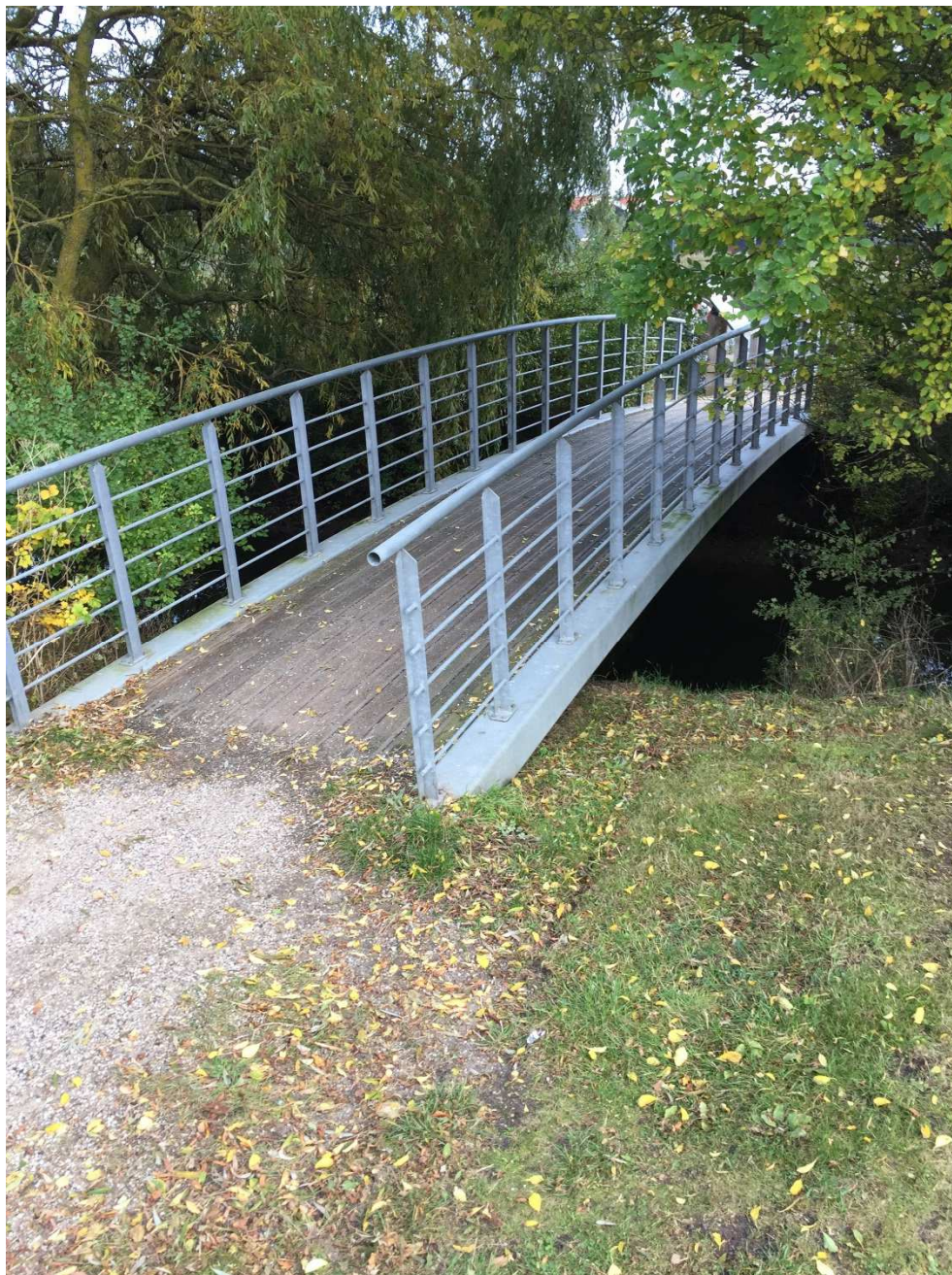
Figur 4-8 Eksempel på stibro med bærende stålkonstruktion, stålrækværk og trædæk (bro ved Barfods Dam, Bogense)
